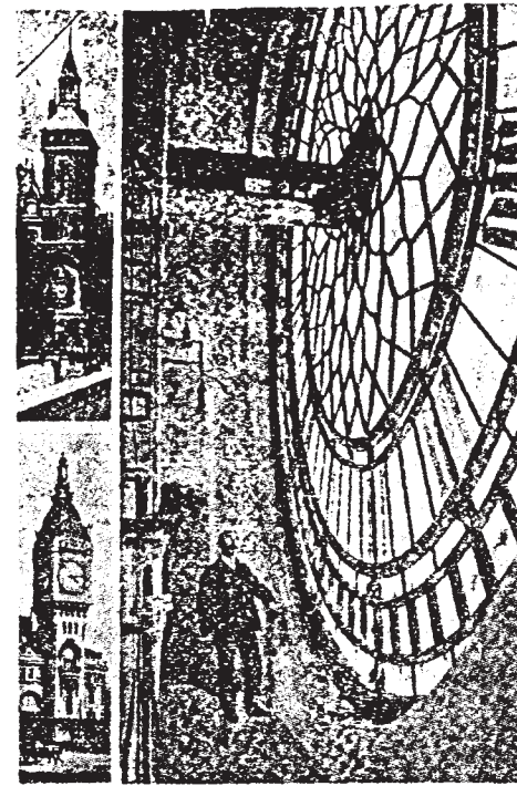
اگر صفحه ساعت را خیلی بزرگ کنند حرکت عقربه‌ها کاملاً مرئی میشود - این عکس پشت ساعت معروف بیک بن لندن است که قطر دایره آن ۷ متر و عقربه یک دقیقه شمار آن ۴ متر است .
